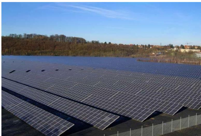
图 2-9 固定式安装方式
